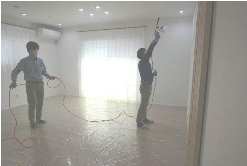
光触媒コーティング施工の様子
