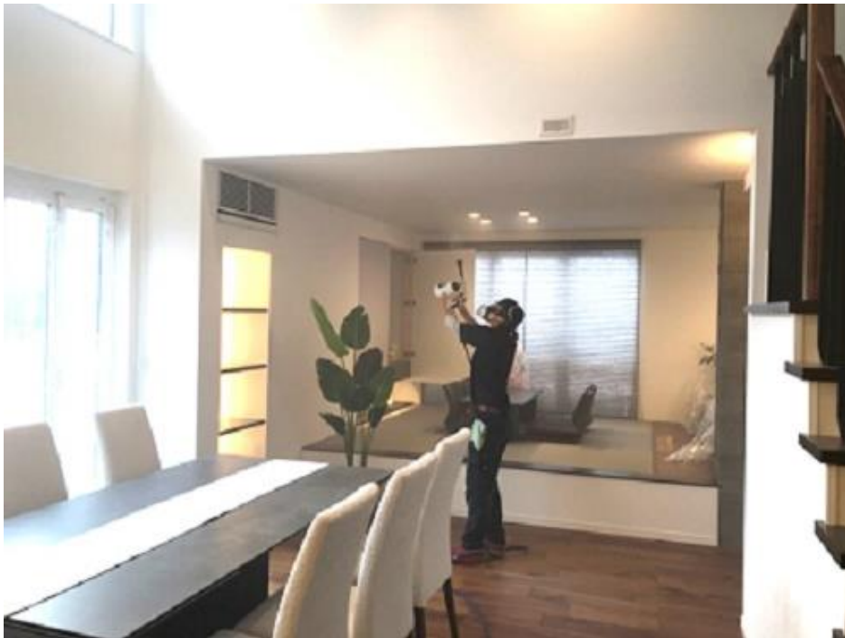
抗ウイルス抗菌コーティング(「レコナガード エアフレッシュ」) 住宅展示場への施工の様子
