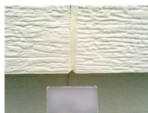
外壁の欠け傷 After
