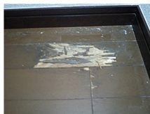
外壁の欠け傷 Before
