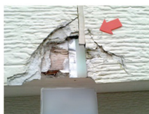
外壁の欠け傷 Before
